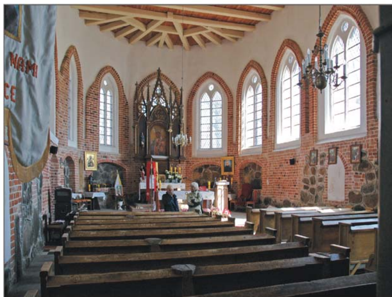
B. Barzowice, wnętrze nawy z łukami tarczowymi planowanych sklepień. Fot. M. Ober, 2006
