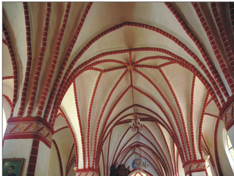
B. Bukowo Morskie, gwiaździste sklepienia nawy głównej kościoła. Fot. M. Ober, 2006
